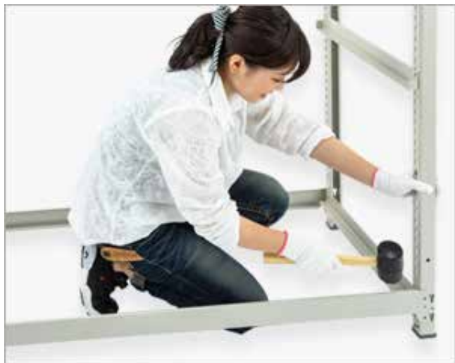
● 枠組みにビームを取付けます
